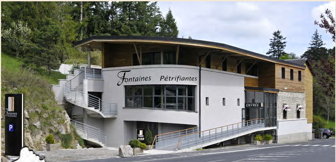
Vue extérieure du bâtiment
