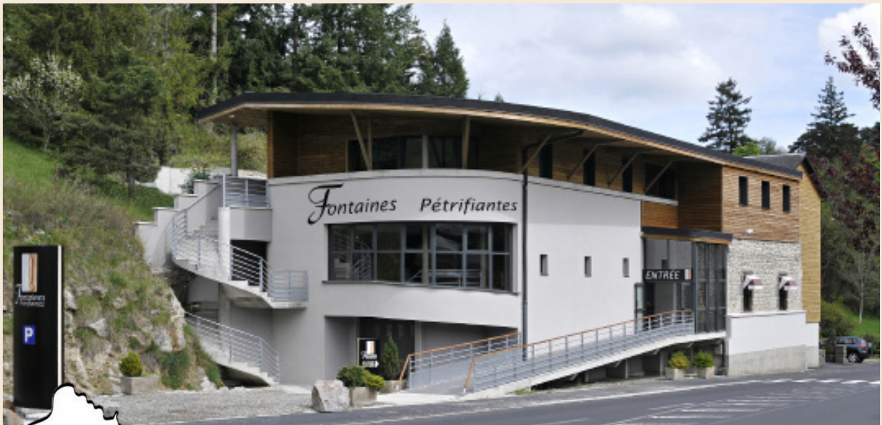
Vue extérieure du bâtiment
